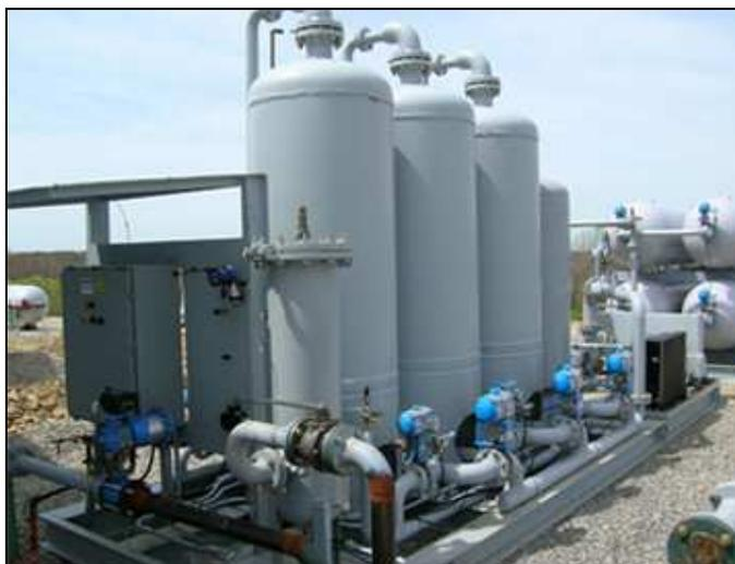
**Pequena central de compressão será construída para comprimir o biogás e armazenar antes de ser enviado para a turbina.**
