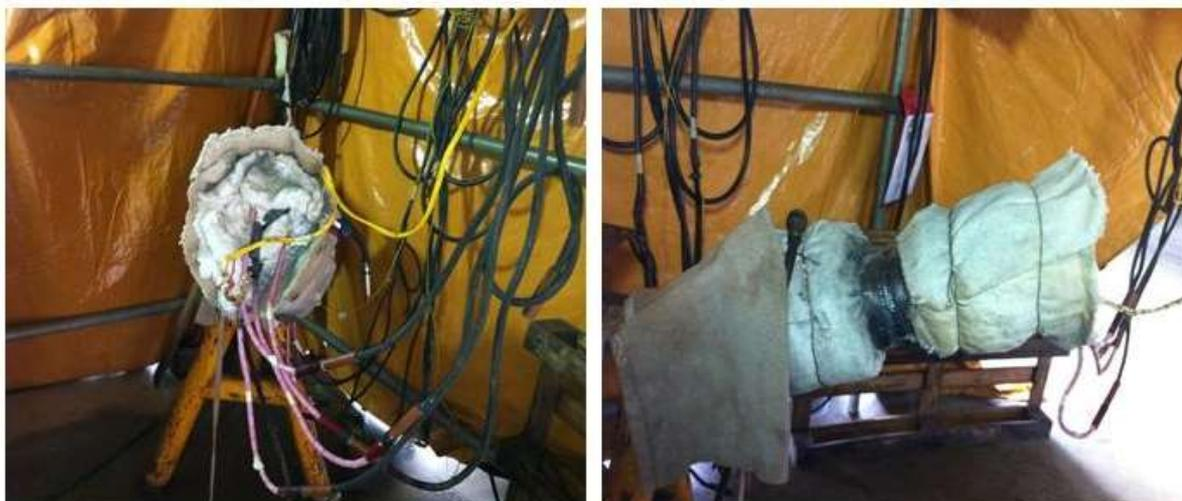
Figura 34. Junta com isolamento térmico.
