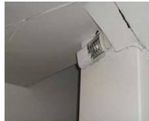
Figura 41 – Iluminação de Emergência. Escada.
