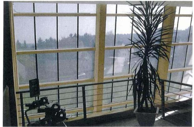
Figura 15 – Edificação com revestimento de Silício Amorfo 10 % Transparente. Fonte: (GREENPRO, 2008).
