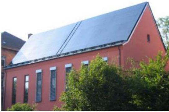
Figura 17 – Integração em telhado com tecnologia CIGS em substrato de vidro para aplicações arquitetônicas. (RÜTHER, 2004).
