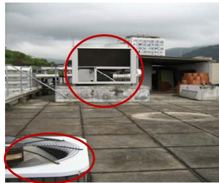
Figura 32 – Visão Frontal do *Chiller* e de um dos Trocadores de Calor.
