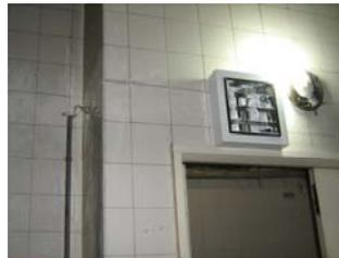
Figura 40 – Iluminação de Emergência. Subsolo.
