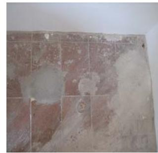
Figura 37 – Vista do Piso desnivelado
