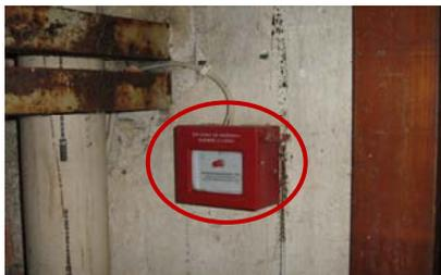
Figura 44 – Sistema de Alarme de Incêndio Manual.
