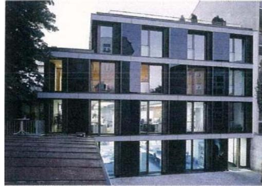
Figura 18 – Integração em fachada com tecnologia CIS em substrato de vidro com revestimento nas janelas. Fonte: (GREENPRO, 2008)
